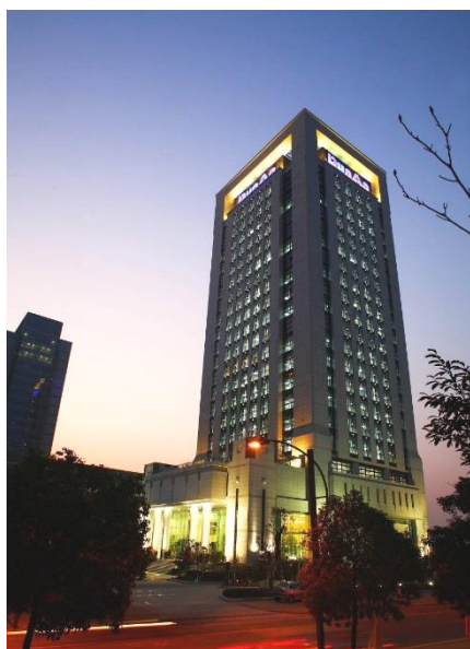
中国本社ビル 盾安発展大厦
